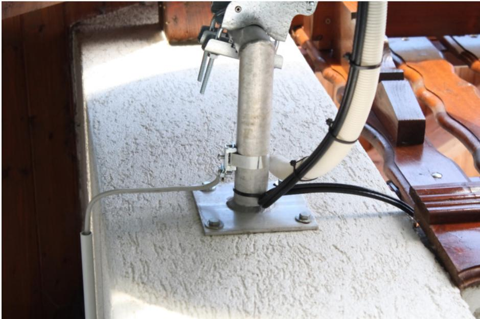
Anschluss des Potentialausgleiches mittels Bänderdungsschelle am Wandausleger
